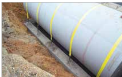
Lavaggi di serbatoi interrati
