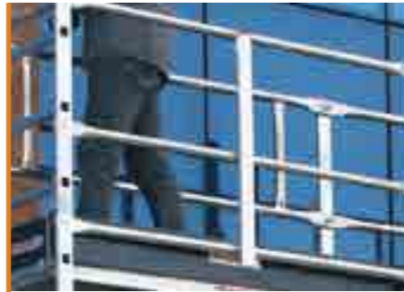
Rinforzo per parapetto. Reinforce for railing.
